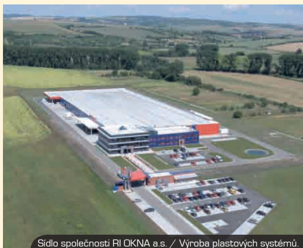
Sídlo společnosti RI OKNA a.s. / Výroba plastových systémů.
